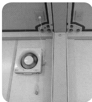
連棟部換気扇側
